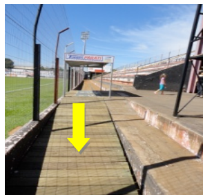
Figura, 08: Rampa Fonte: Mira (2011).
