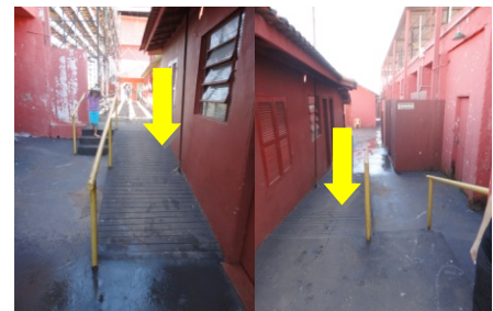
Figura, 09: Rampa Fonte: Mira (2011).
