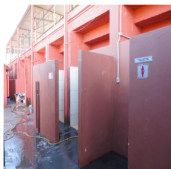
Figura, 14: Sanitários feminino Fonte: Mira (2011).
