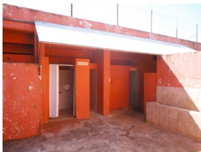
Figura, 10: Sanitário masculino Fonte: Mira (2011).
